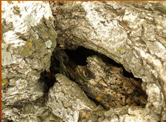
Вид прожжённого канала сверху
