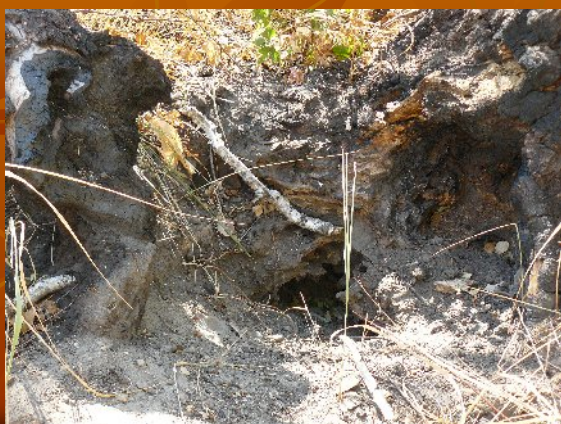
След земного разряда. Участок 1
